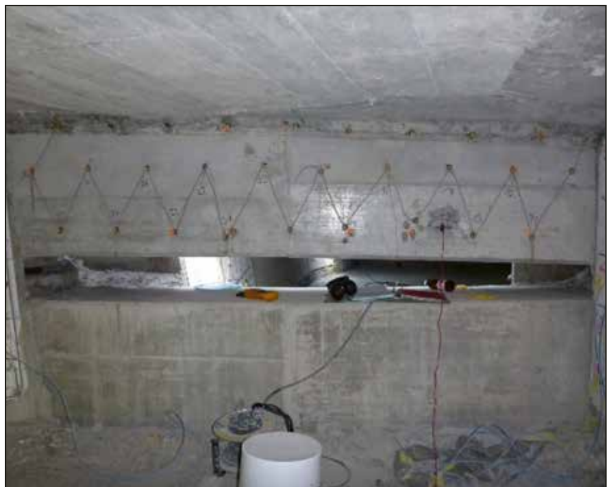
Abbildung 5: Montage von Überkopf-Stabanoden
