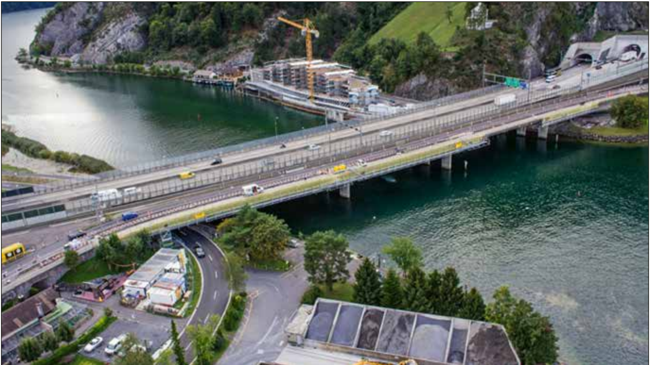
Abbildung 2: Ansicht der Achereggbrücke bei Stansstad (Quelle: luftbild-drohne.ch)
