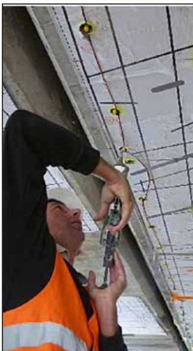
Abbildung 5: Montage von Überkopf-Stabanoden
