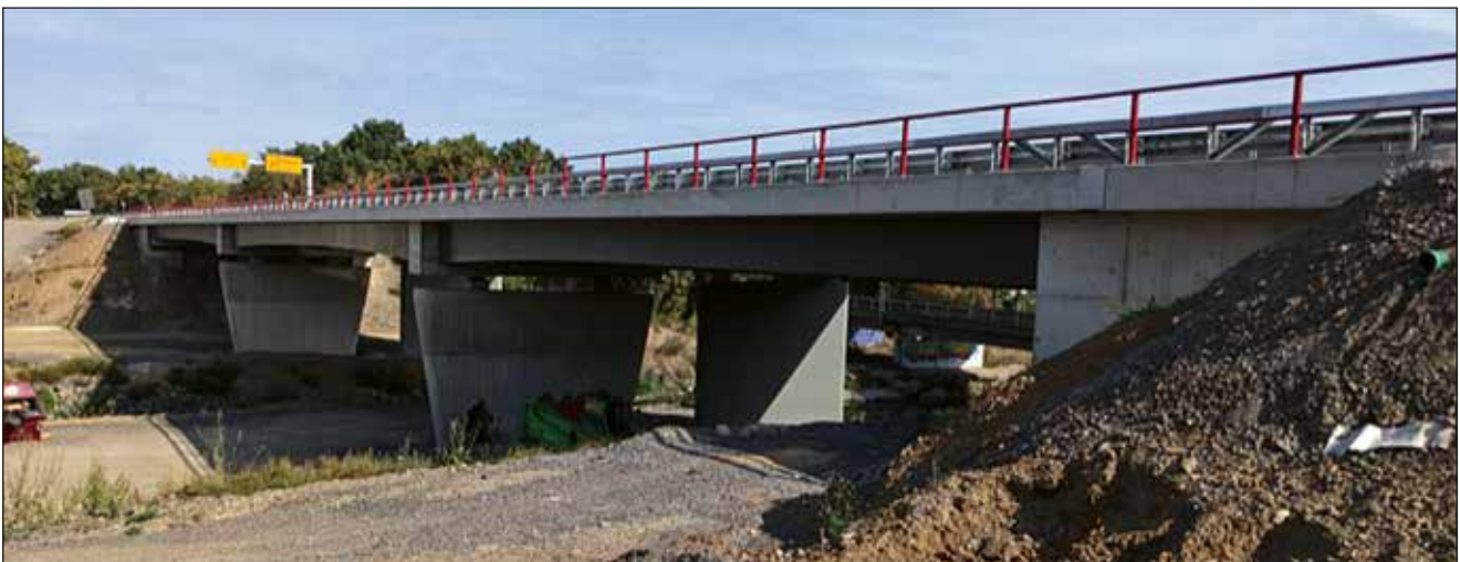
Abbildung 2: B 9 – Ahrbrücke Sinzig am 30. August 2022 vor der Verkehrsfreigabe
