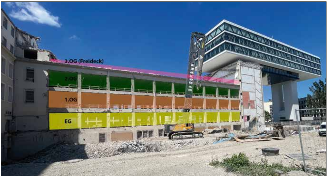
Abbildung 1: Gebäude 1500 nach Rückbau und vor ECE
