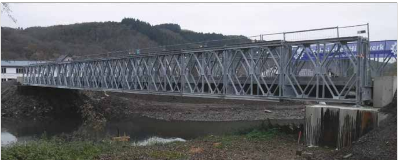
Abbildung 6: Ahrbrücke Insul, Mabey Compact, errichtet vom THW, November 2021
