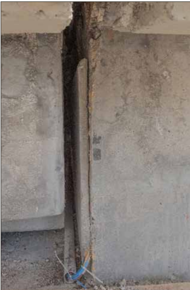
Abbildung 12: KKS-Fläche im Zwischenraum (Nr. 1)
